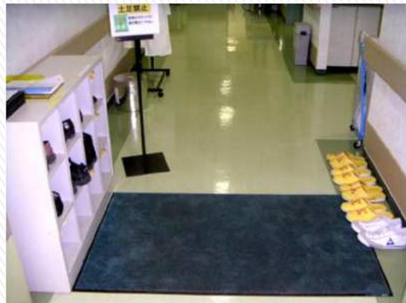
薄いマットを採用し転倒事故を防ぐ工夫がなされている例。
